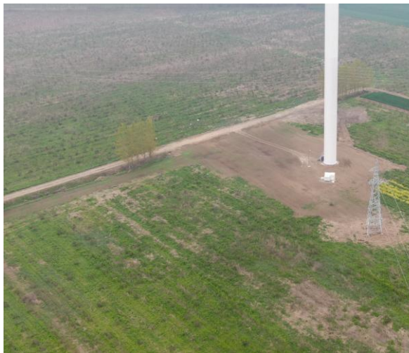
风机安装场地撒播草籽绿化
